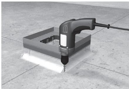
Fixez la boîte de jonction sur la dalle en veillant à ce que la jupe en PVC soit à l'extérieur de la boîte de jonction. Ajustez la hauteur et le niveau de la boîte de jonction à l'aide des 4 vis situées dans les coins de la boîte de jonction.
