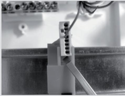
2. Maintenir le conducteur dans une main et retirer doucement la borne par des mouvements rotatifs.
