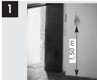
Le poste intérieur doit être fixé au mur. Repérez une surface plane. Pour des raisons de facilité d'utilisation, nous vous conseillons de le fixer à environ 1 m 50 du sol.
