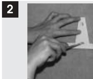
Repérez les 2 points de fixation de la pièce de fixation. Percez (foret  $\varnothing$  6 mm) puis vissez la pièce sur le mur (vis fournies).
